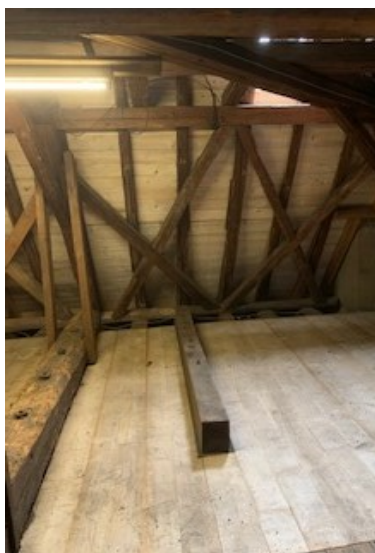
... und nach den Arbeiten
